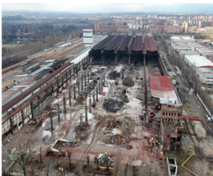
Fig.23 Demolizione parziale del laminatoio. Fonte: https://www.facebook.com/perinopierotorino
